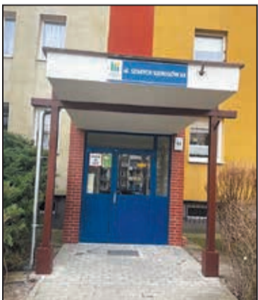
Odnowiony wiatrołap w budynku przy ul. Szarych Szeregów 68
