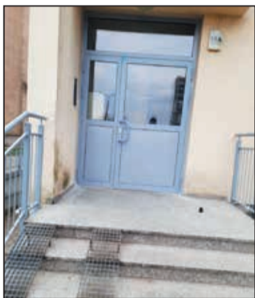
Nowe drzwi wejściowe do budynku przy ul. Hubala 18A
