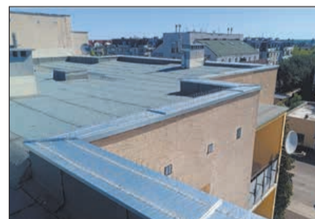
Pokrycie dachu przy ul. Bielskiej 32-40
