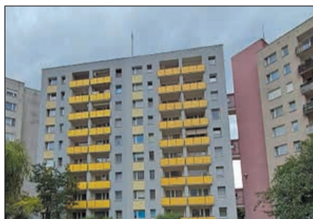
Elewacja przy ul. Fieldorfa 10a-b
