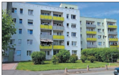
Elewacja przy ul. Hubala 5a-f
