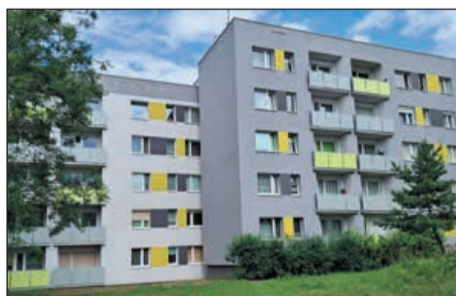
Loggia przy ul. Bytnara Rudego 15a-f
