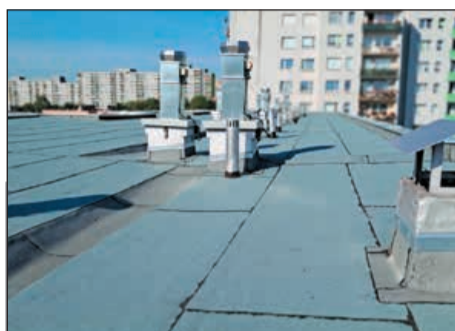
Dach budynku przy ul. mjr Hubala 3a-d
