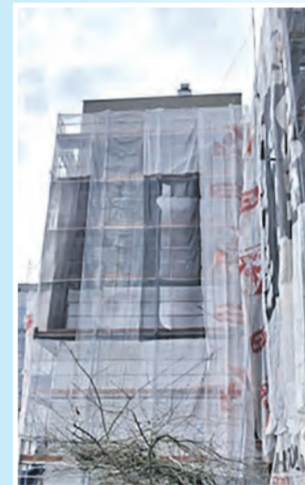
Budynek przy ul. Szarych Szeregów 25-31 – widok elewacji w trakcie remontu
