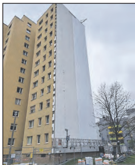
Termomodernizacja i remont elewacji budynku przy ul. Grota Roweckiego 14
