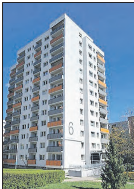
Termomodernizacja i remont elewacji budynku przy ul. Fieldorfa 6
