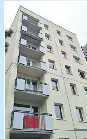
Budynek przy ul. Skautów Opolskich 1 – widok elewacji po remoncie
