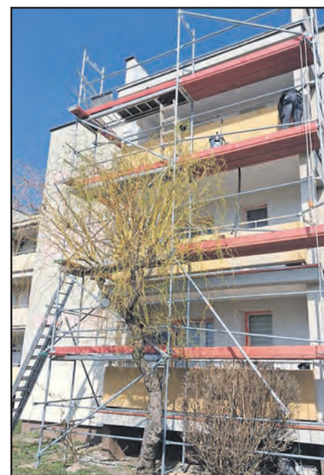
Remont loggii na budynku przy ul. Cieszyńskiej 12
