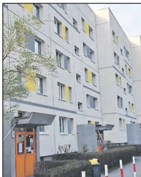
Remont elewacji budynku przy ul. Szarych Szeregów 15-21
