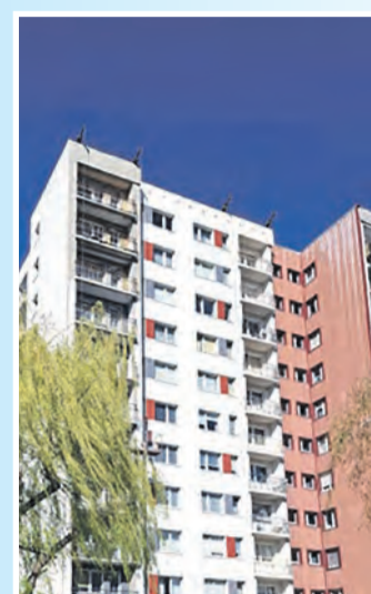
Budynek przy ul. Bytnara Rudego 17 – widok elewacji po remoncie
