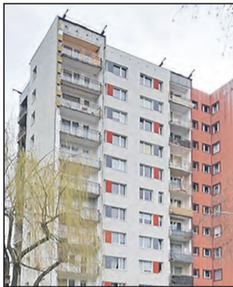
Termomodernizacja i remont elewacji budynku przy ul. Jana Bytnara Rudego 17
