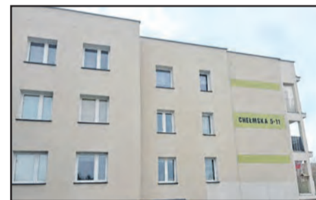
Elewacja budynku Chełmska 5-11: po umyciu
